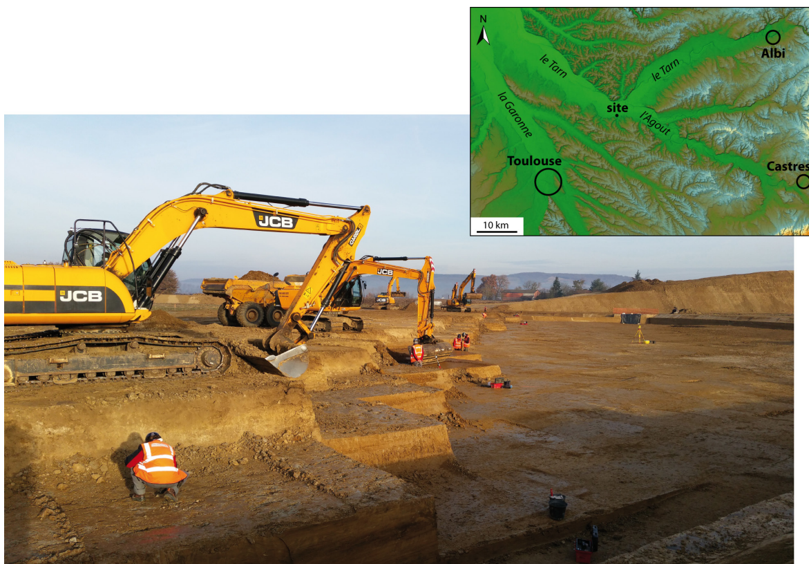
Fig. 1 – Localisation du site dans la basse vallée du Tarn et vue du décapage du secteur 3 (cliché Paléotime).
