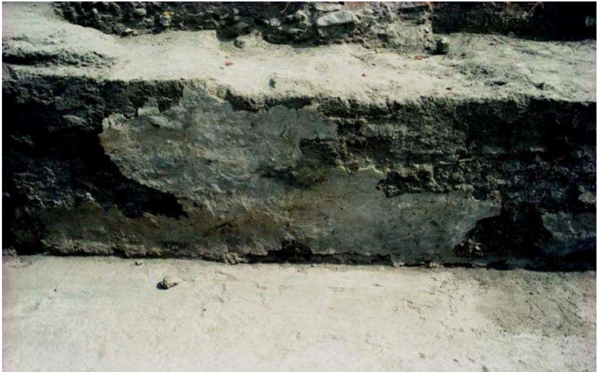
Mur en adobe recouvert de stuc dans l'Edifice 4 de Tula Grande (d'après Báez Urincho 2008)
