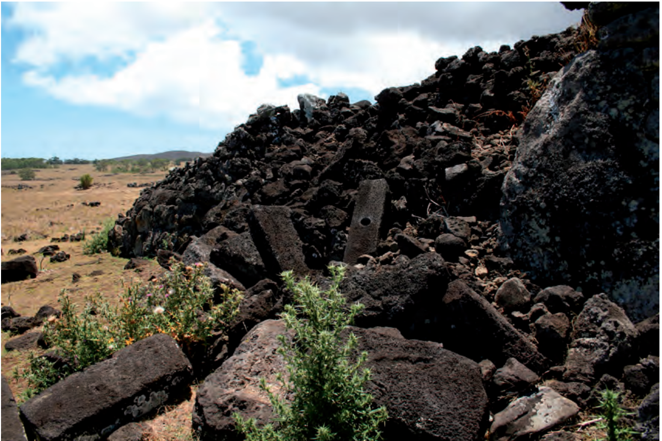
Fig. 4 – Ahu te Peu (côte ouest). À quelque chose, malheur est bon : l’effondrement partiel du mur arrière de l’ ahu a permis de constater la présence de paenga (pierres de fondation de maisons) dans le remplissage de la plate-forme (cliché N. Cauwe).
