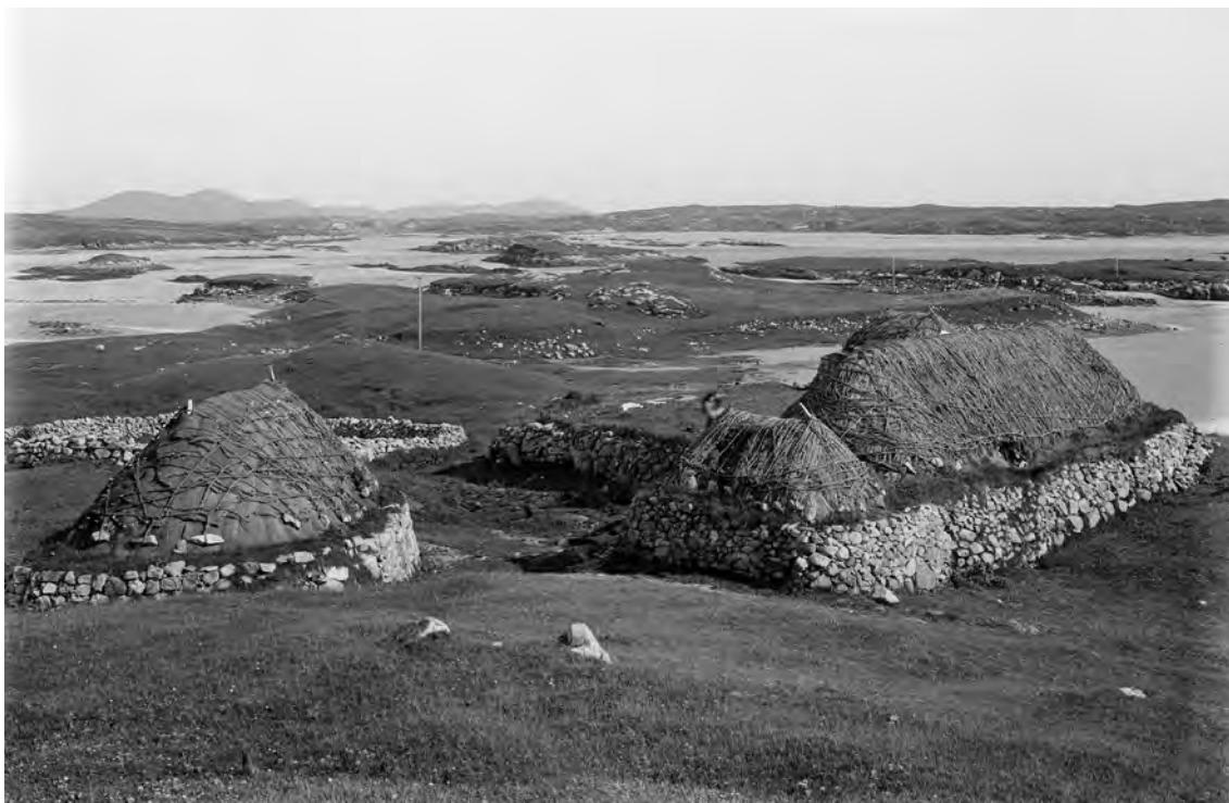
Fig. 6 – Black houses à Eilean a' Ghiorr, île de North Uist, Hébrides. Ces maisons en pierres sèches datent probablement du début du XIX e siècle. Les toits sont couverts de chaume (maison de droite) ou de mottes de pelouse retournées (maison de gauche), le tout maintenu par un réseau de cordages lesté par des pierres. Aux extrémités du faitage, deux bâtons, nommés les « bâtons de corbeaux » ( raven-sticks ), servent de point d'ancrage au réseau de cordes (photographie Erskine Beveridge, 13/08/1906, © RCAHMS).
