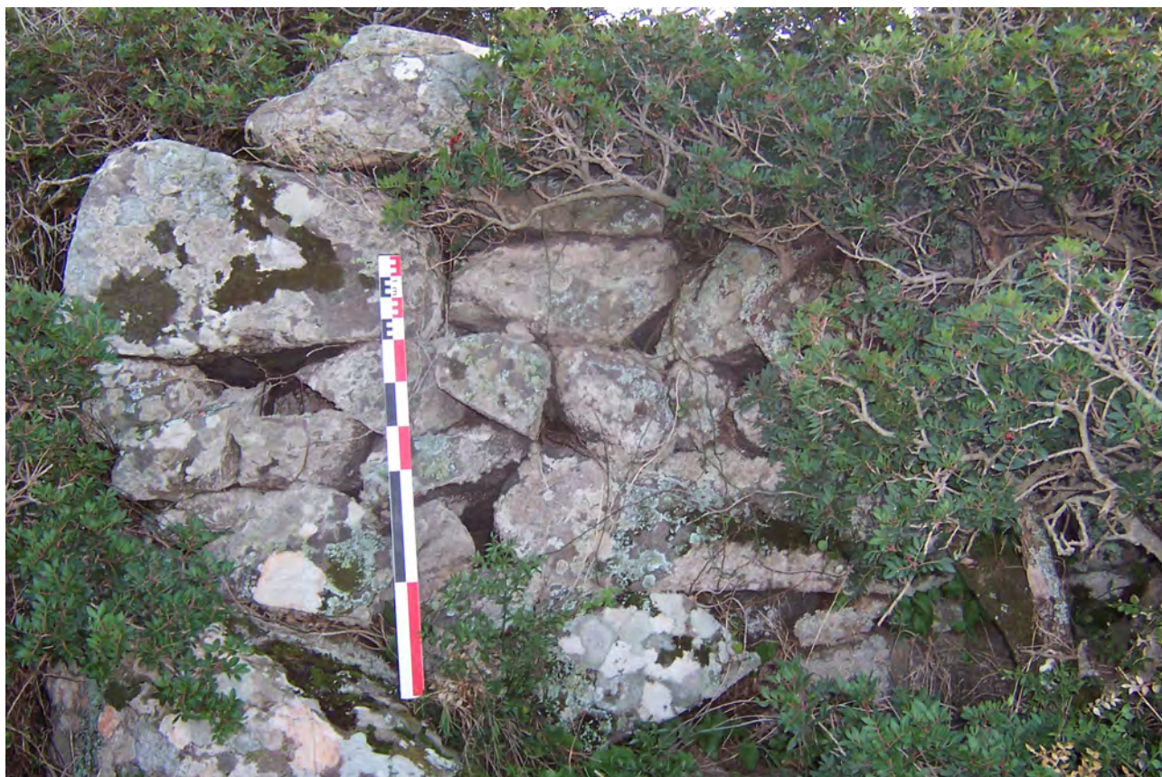
Fig. 3 – Parement extérieur de l'enceinte du site fortifié de A Sora (photo K. Peche-Quilichini). Fig. 3 – Outside facing of the enclosure wall at the defensive site of A Sora (photograph K. Peche-Quilichini).
