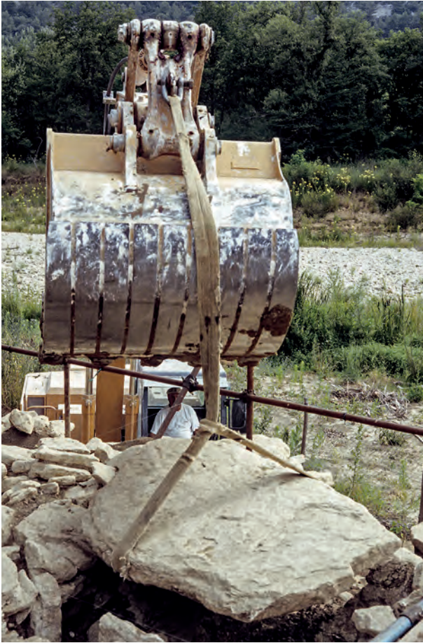
Fig. 8 – Dépose des deux dalles de couverture encore en place (G.S.).
